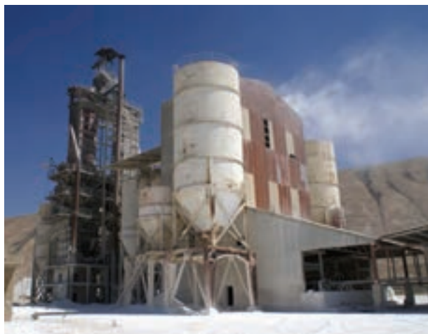
شکل ۳-۱۴- کارخانه آهک هیدراته پلدختر
